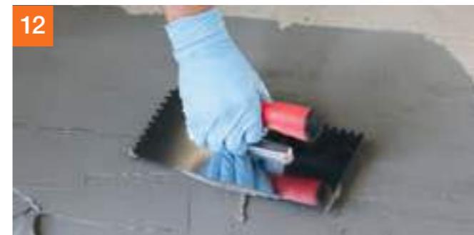
Kratzspachtelung mit PCI Seccoral® 2K Rapid ausführen.
