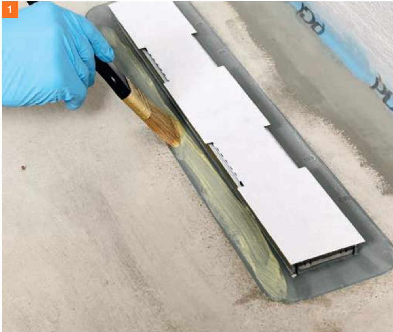
Grundierung des Anschlussflansches mit PCI Gisogrund® 303 oder PCI Gisogrund® 404 im mäßig belasteten Bereich, bei hoher Beanspruchung mit PCI Epoxigrund.
