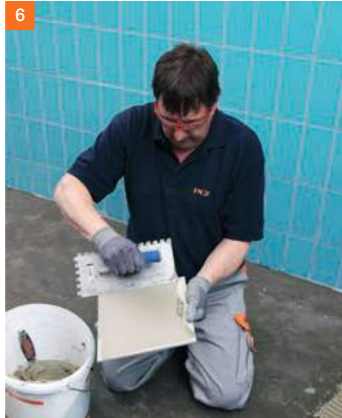
... wird das Buttering-Floating-Verfahren angewendet.
