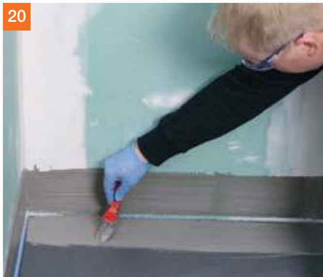
20 Abdeckung entfernen und im Randbereich PCI Seccoral® 1K / 2K Rapid vorlegen.
