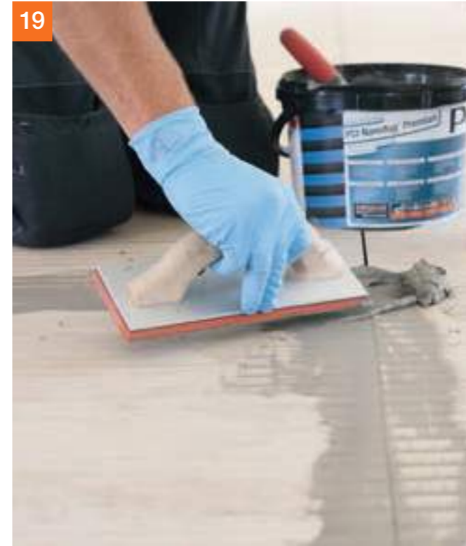
19 Fliesenbelag mit PCI Nanofug® Premium einfügen ...
