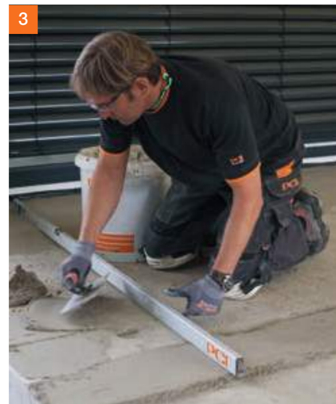
3 Lehren aufziehen und Flächenspachtelung mit PCI Pericret® ausführen.
