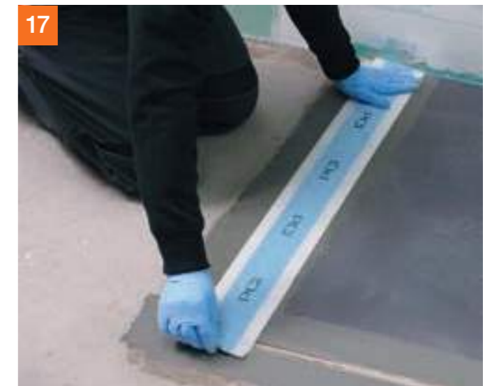
17 ... PCI Pecitape® 120 einlegen, andrücken ...
