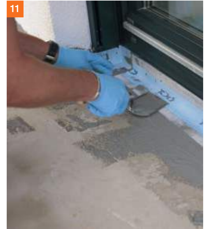
PCI Pectape® 120 in PCI Seccoral® 2K Rapid einlegen.
