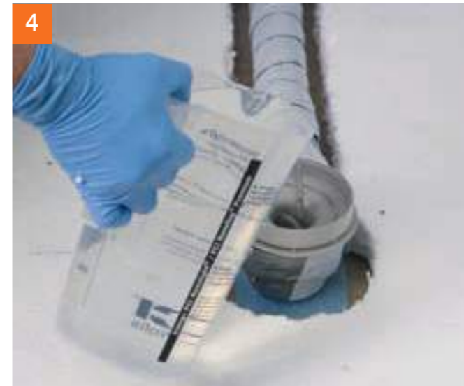
Vor Beginn der weiteren Arbeiten wird eine Dichtigkeitsprüfung durchgeführt.
