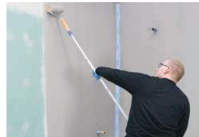
Flüssigabdichtungen sind immer mindestens 2-lagig auszuführen.
