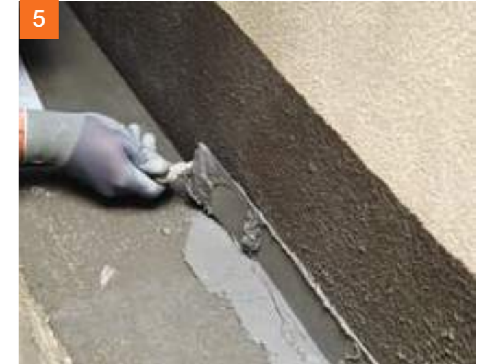
5 Zur Abdichtung von Kanten (zum Beispiel Wand-/Bodenanschlüssen) wird PCI Seccoral® 1K / 2K Rapid vorgelegt ...
