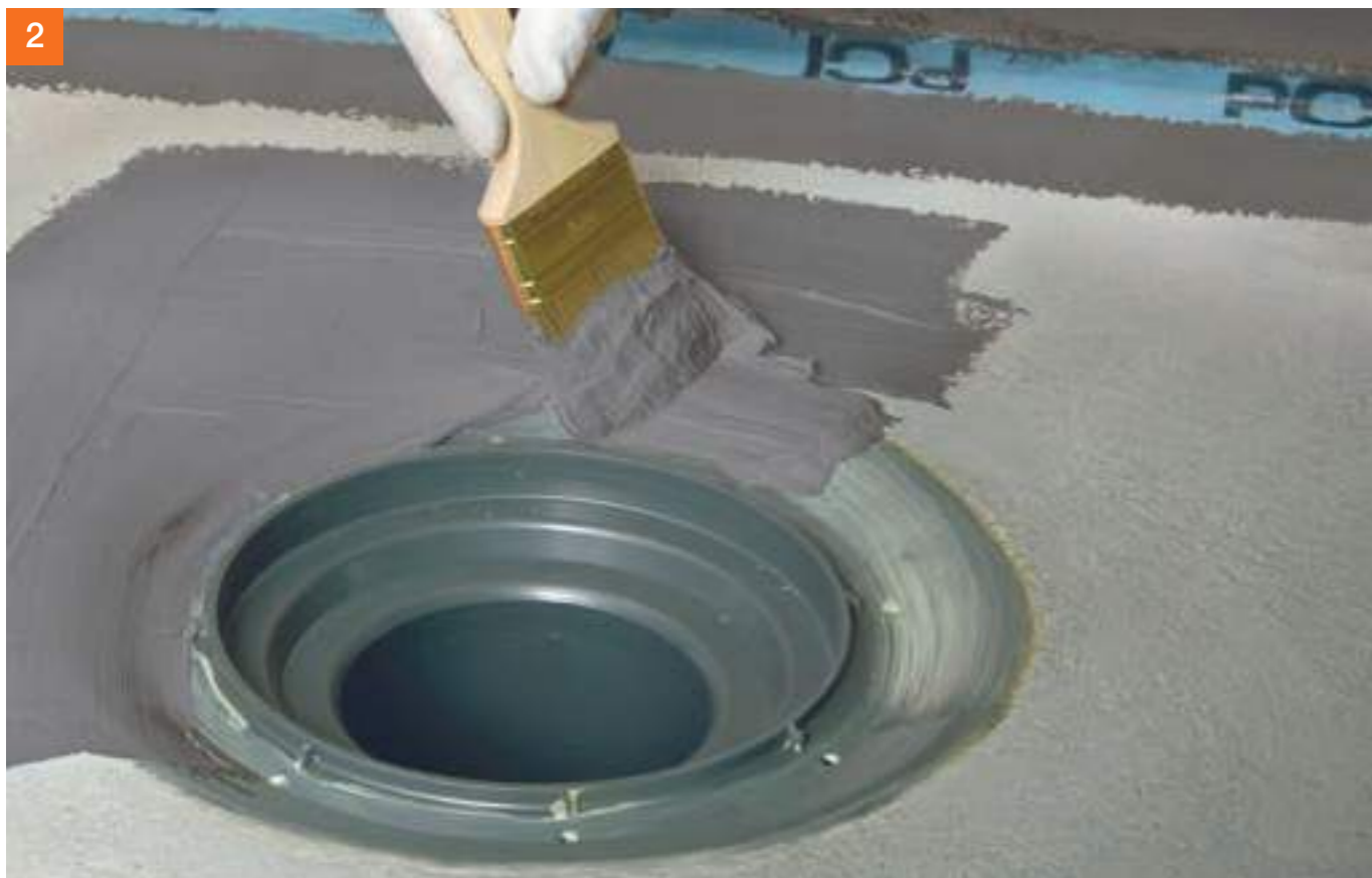
PCI Seccoral® 1K / 2K Rapid vorlegen ...
