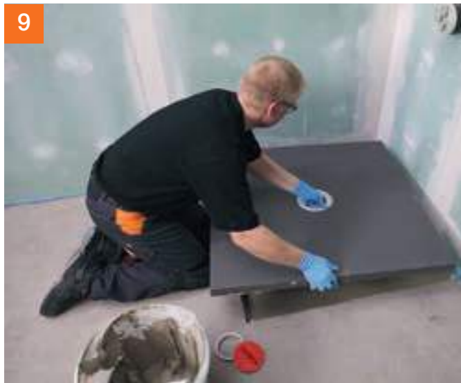
9 ... und das PCI Pecibord® ansetzen und andrücken, bis der Dichtungsring den Rand des Bodenablaufs sauber umschließt.
