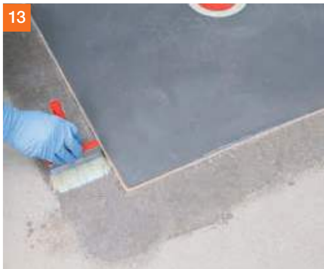
13 Estrich im Übergangsbereich mit Wasser vornässen.
