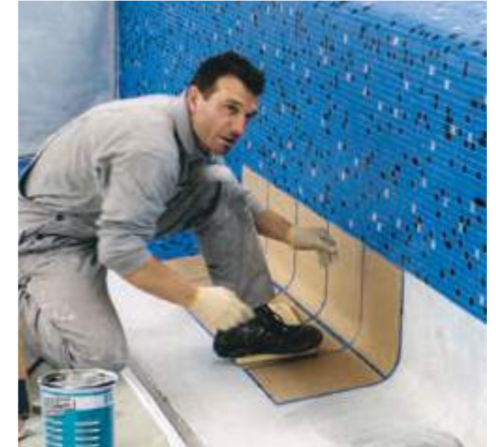
... werden keramische Beläge sicher auf Stahlkonstruktionen verlegt.
