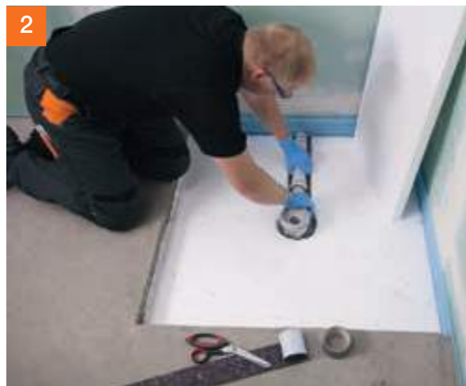
Der Ablauftopf wird an das vorhandene Ablaufrohr angeschlossen ...
