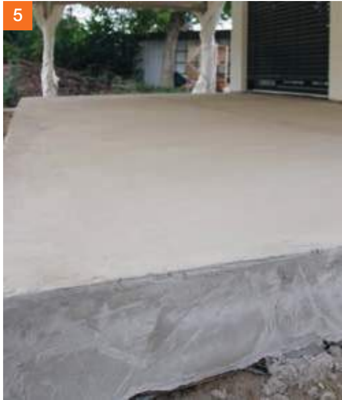
Terrassenplatte mit PCI Pericret® im Gefälle gespachtelt.
