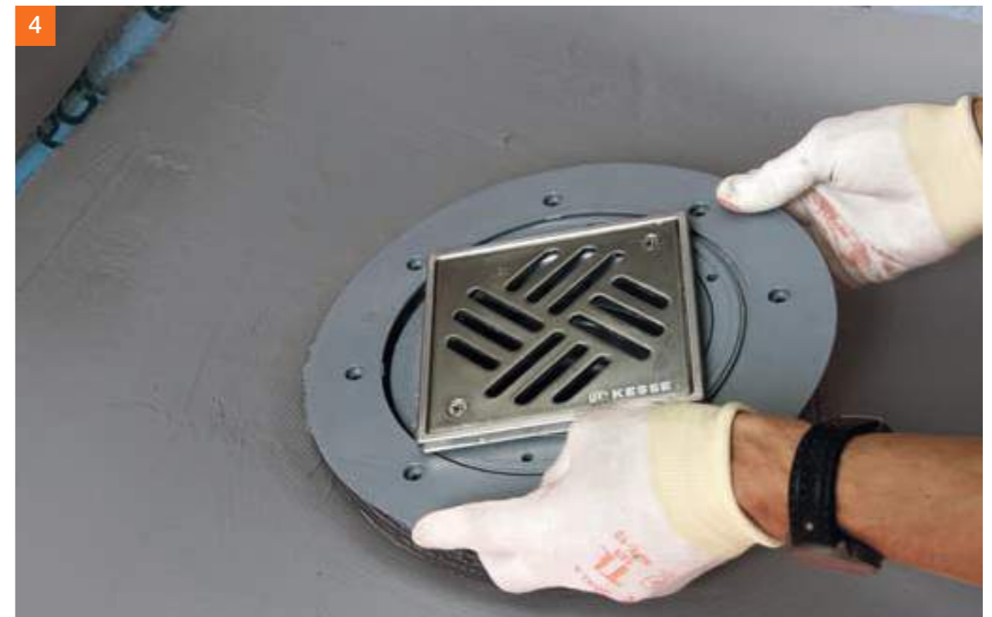
Klemmflansch aufsetzen und festschrauben.
