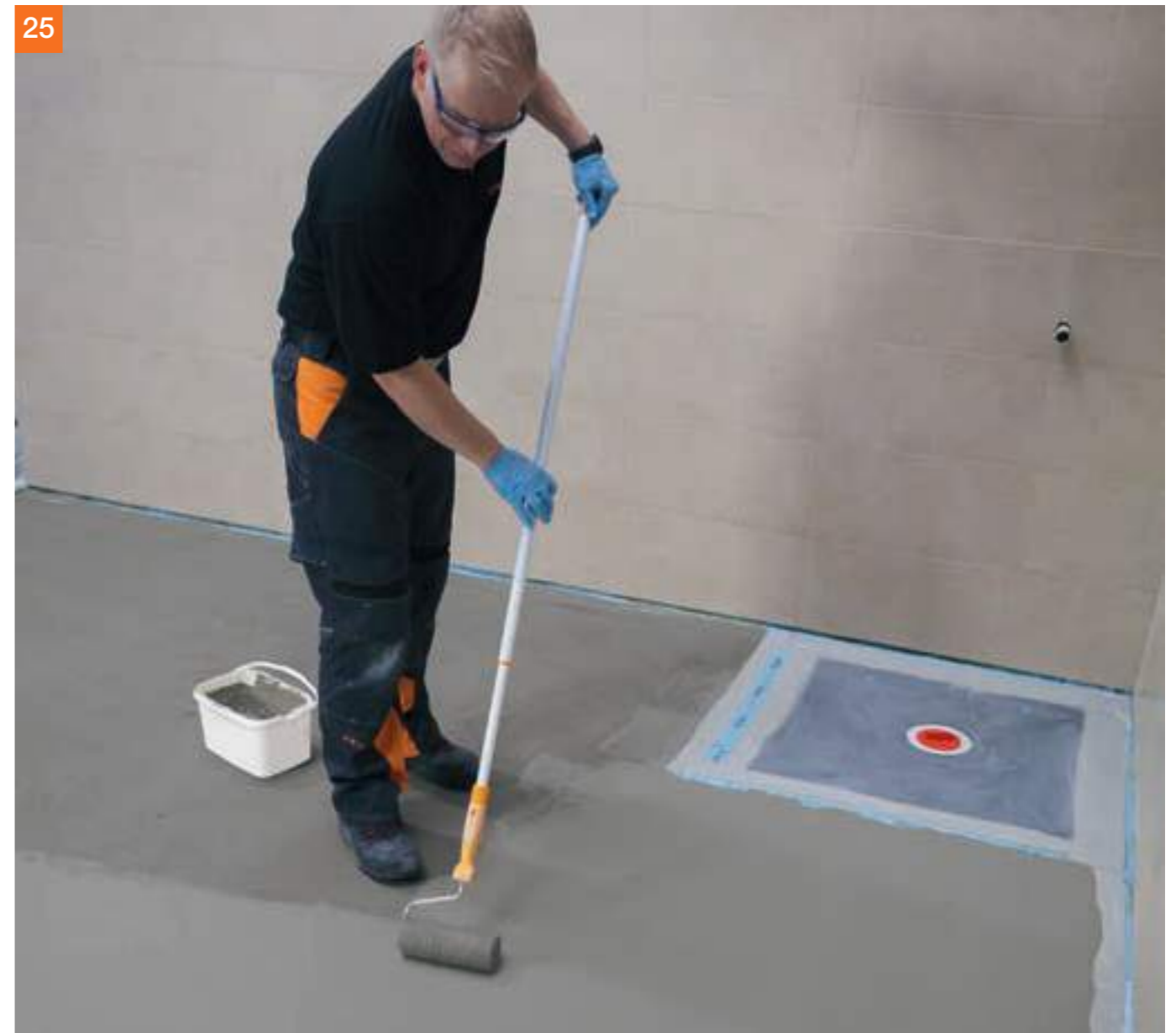
25 Nach ca. 1 Stunde erfolgt der 2. Auftrag mit PCI Seccoral® 1K / 2K Rapid.
