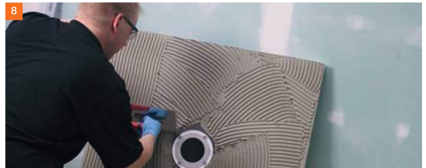
Zunächst eine Kratzspachtelung auf dem Unterbau und der Rückseite des PCI Pecibord® ausführen, den Kleber aufkämmen ...
