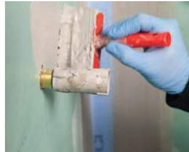
Abdichtensmaterial (PCI Seccoral® 1K/2K Rapid oder PCI Lastogum®) vorlegen...
