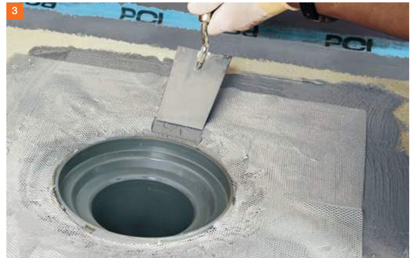
... anschließend das Gewebe entsprechend dem Gefälleverlauf andrücken und mit PCI Seccoral® 1K / 2K Rapid überarbeiten. Nach Durchtrocknung (ca. 1 Stunde) erfolgt der 2. Arbeitsgang mit PCI Seccoral® 1K / 2K Rapid.
