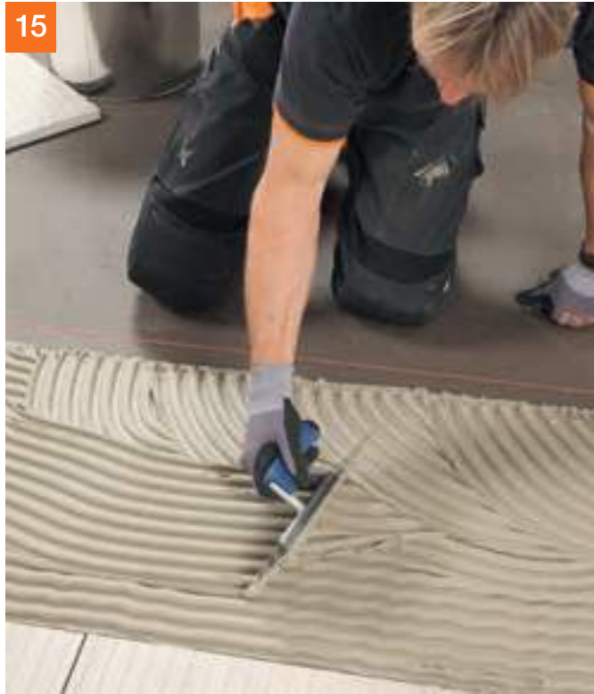
15 PCI Flexmörtel® Premium Kleberbett aufziehen.
