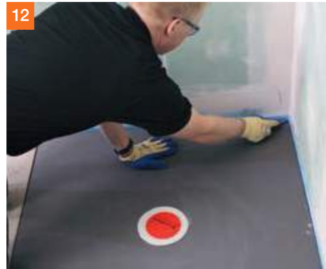
12 Den Randdämmstreifen bündig mit der Oberkante des PCI Pecibord® abschneiden.
