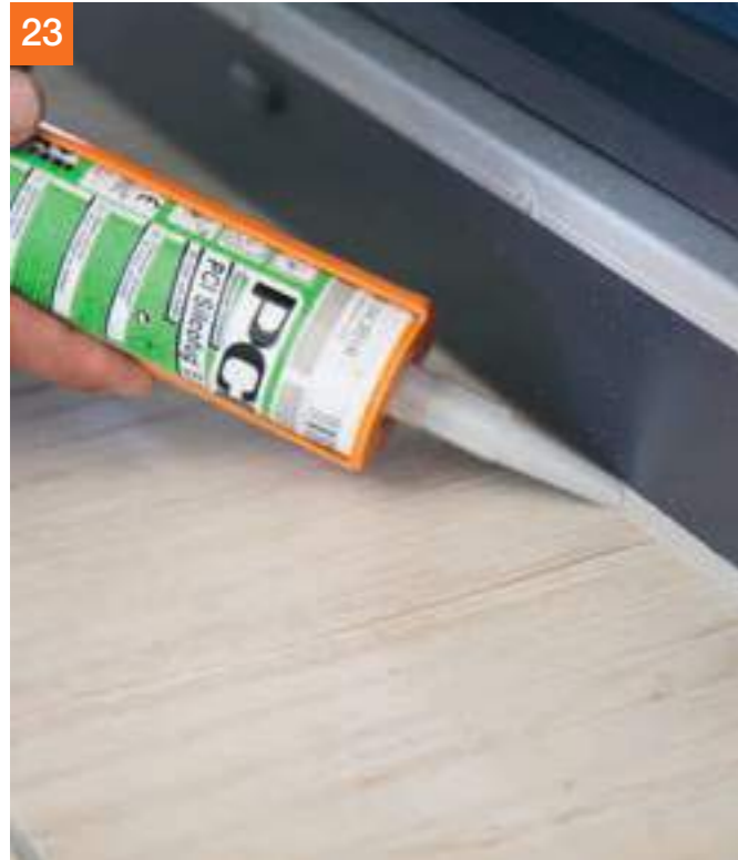
23 Silikonieren mit PCI Silcofug® E oder PCI Silcoferm® S im Anschlussbereich zum Kunststofffenster.
