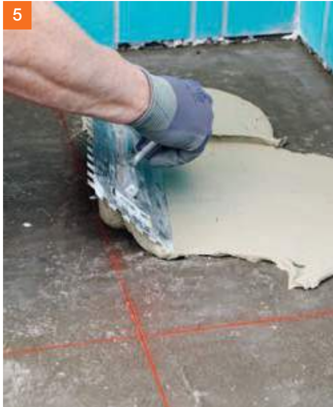
Auch bei der Verlegung der Bodenfliesen ...
