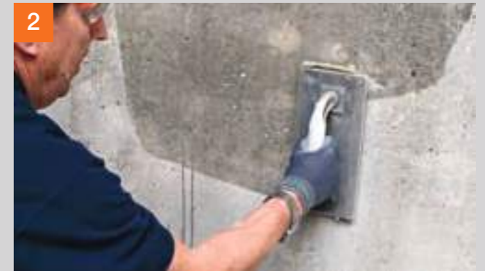
2 Zur Regulierung des Saugverhaltens den Untergrund leicht anfeuchten oder abhängig von der nachfolgenden Anwendung mit PCI Gisogrund® oder PCI Gisogrund® 404 grundieren.
