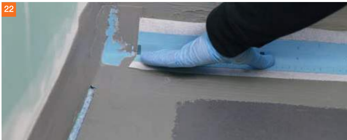
22 ... dann PCI Pecitape® 120 einlegen, andrücken ...
