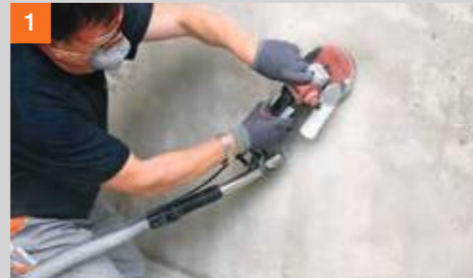
1 Grate und grobe Unebenheiten mittels Handfräse egalisieren.
