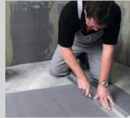
PCI PowerBoard-Elemente mit einem Cuttermesser auf Maß schneiden.
