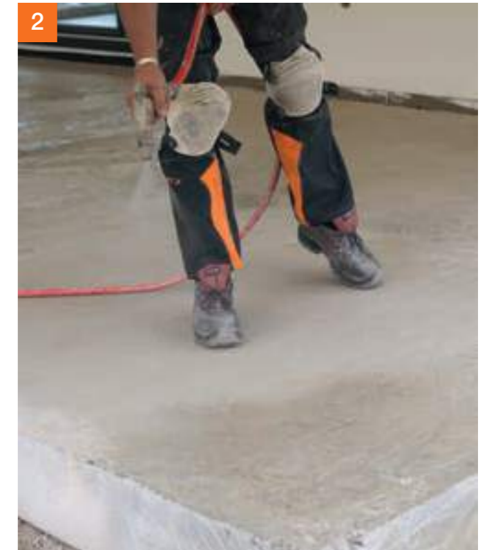
2 Untergrund vornässen für die Aufbringung der Ausgleichspachtelung.
