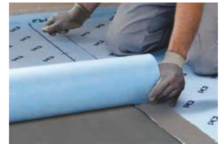
Die Stöße der Bahnen müssen ca. 5 bis 10 cm überlappen. Die Überlappung der Bahnen mit PCI Seccoral® 1K / 2K Rapid einstreichen und innerhalb der kleoeffenen Zeit die folgende Bahn eingelegt und sorgfältig angedrückt.
