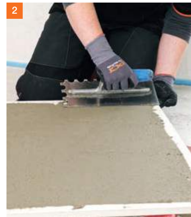
2 Aufbringen der rückseitigen Kratzspachtelung, um eine nahezu hohlraumfreie Verlegung zu gewährleisten.
