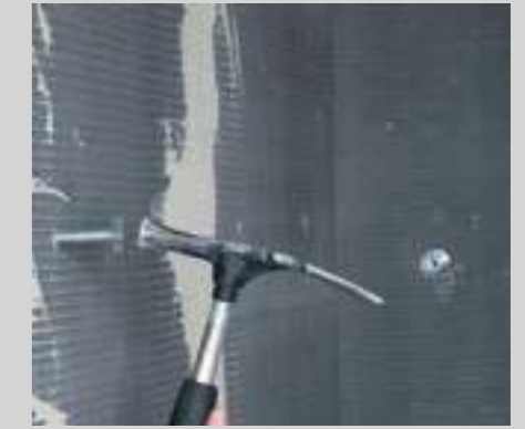
Zu guter Letzt die Schlagdübel einschlagen.
