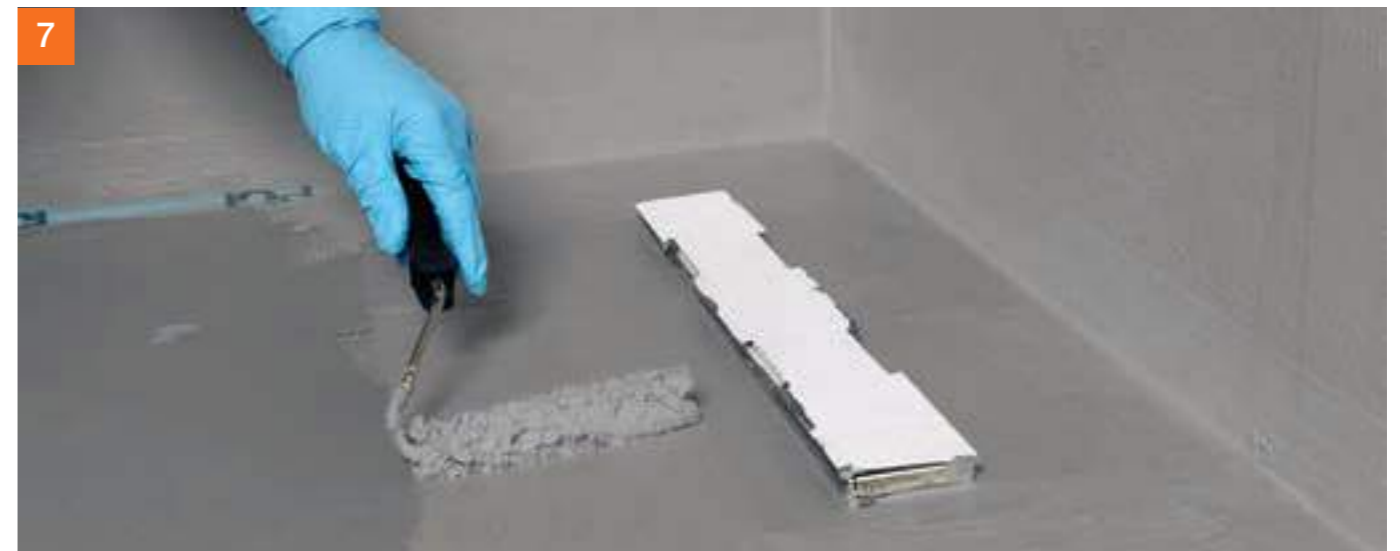
Nach einer Wartezeit von ca. 1 Stunde erfolgt der 2. Auftrag.
