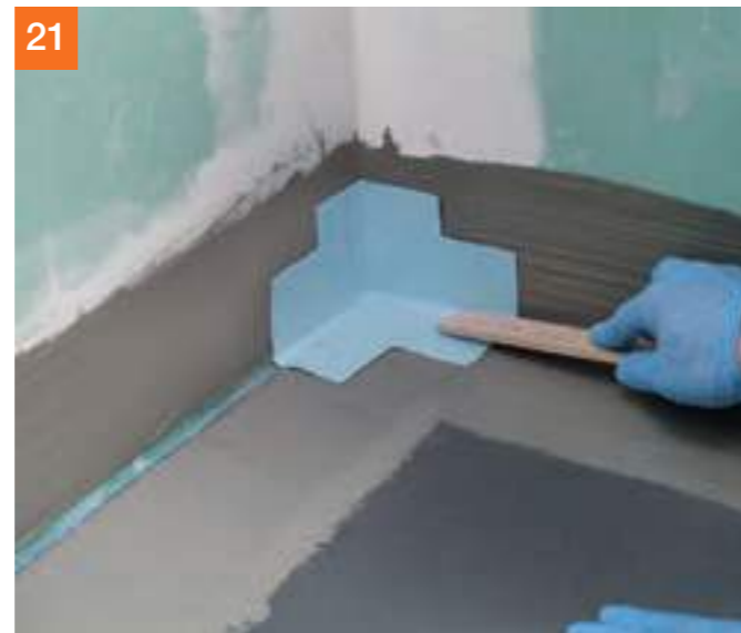
21 Vorgefertigte Spezial-Innenecke PCI Pecitape® ...
