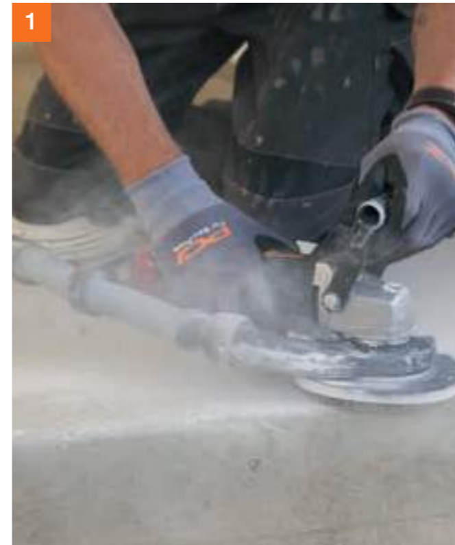
1 Untergrundvorbereitung: Grate entfernen.
