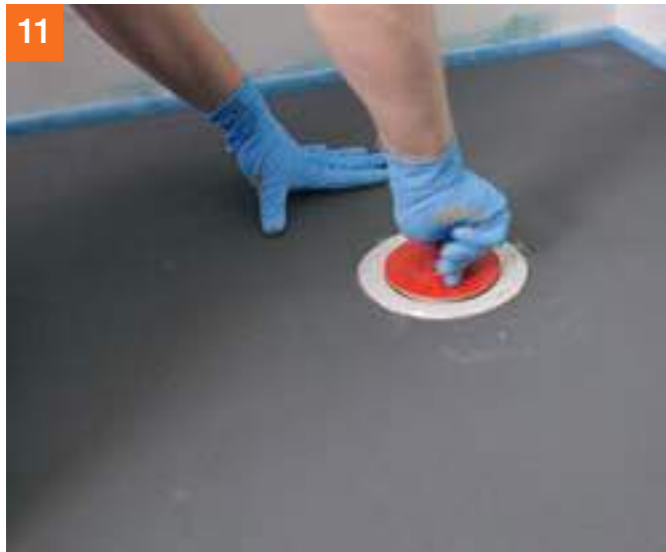
11 ... anschließend das PCI Pecibord® mittels Baustopfen fest mit dem Bodenablauf verschrauben. Der Baustopfen stellt sicher, dass der Bodenablauf durch nachfolgende Arbeitsgänge nicht verunreinigt wird.
