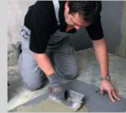
Den Klebemörtel mittels Zahntraufel auf der Plattenrückseite aufziehen. Bei größeren Unebenheiten kann in der „Batzenmethode“ gearbeitet werden.
