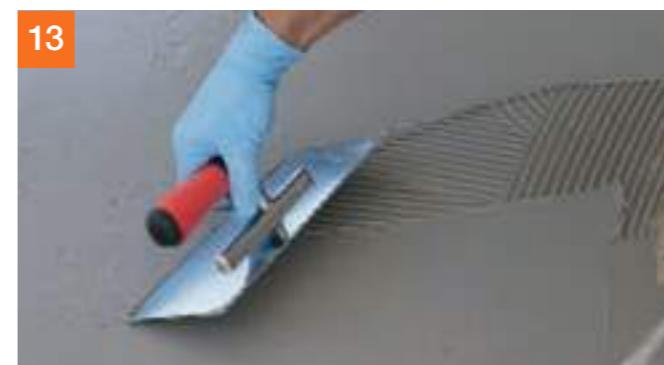
PCI Seccoral® 2K Rapid mit 6er Zahnung aufkämmen und anschließend glattstreichen; nach ausreichender Trocknung der ersten Schicht den zweiten Auftrag in gleicher Weise vornehmen.
