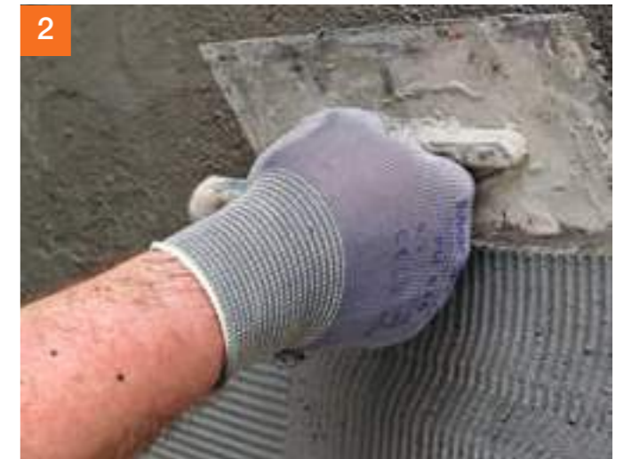
2 1. Auftrag PCI Seccoral® 1K / 2K Rapid. Ziehen Sie die Abdichtung mit einem Zahnschpachtel (6 mm) auf ...
