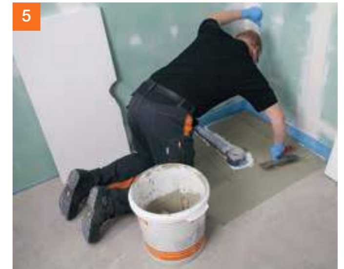
Die Höhenanpassung erfolgt mit Polystyrol-Hartschaumplatten in entsprechender Stärke.
