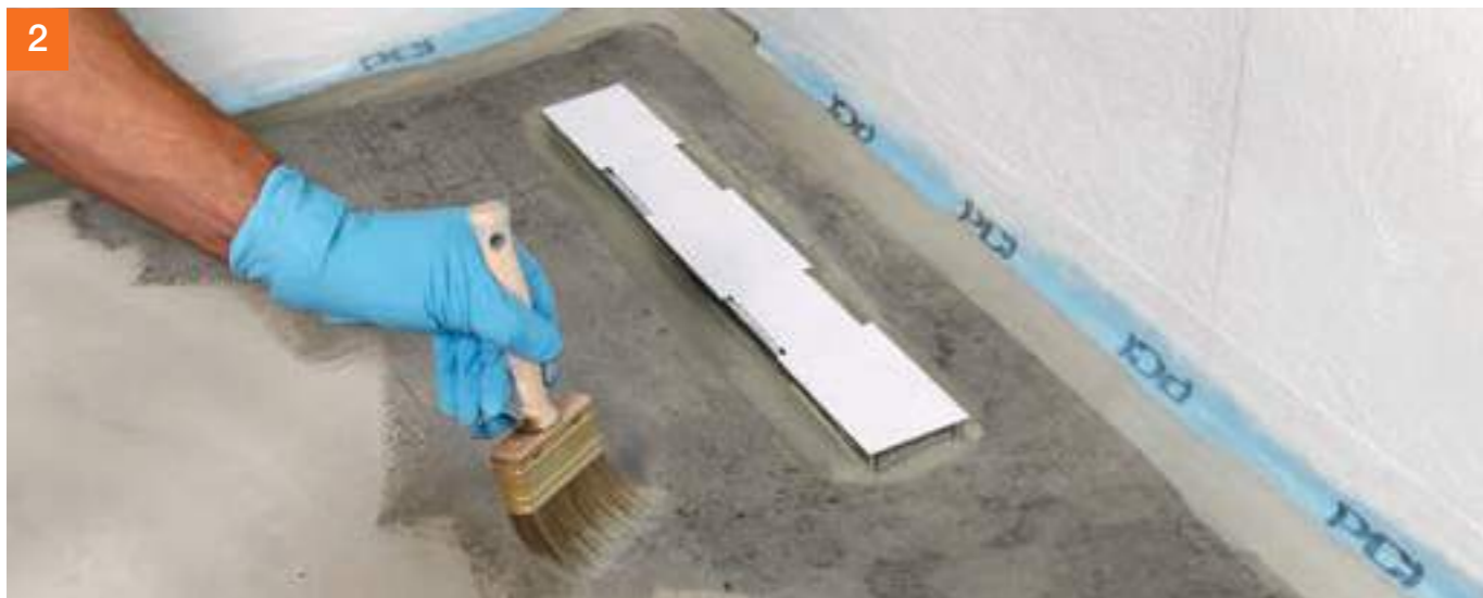
Die übrige Bodenfläche wird vorgehässt und mit verdünntem PCI Seccoral® 1K / 2K Rapid grundiert.
