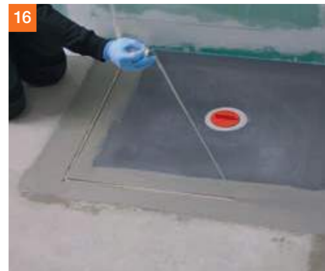
16 ... Klebestreifen abziehen ...
