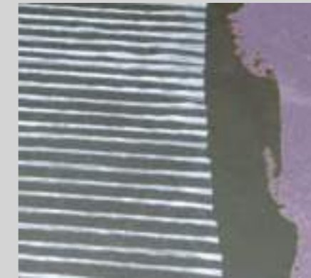
Eingelegte PCI Armiermatte GFS nach dem Abziehen der Trägerfolie.
