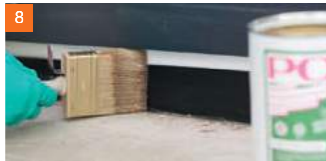
Element grundieren mit PCI Epoxigrund 390 ...
