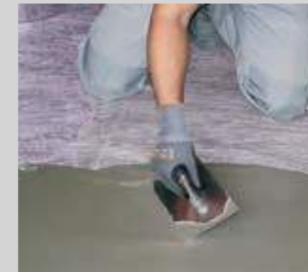
Mit einer Glättkelle verteilen (keine Raketel verwenden!) ...
