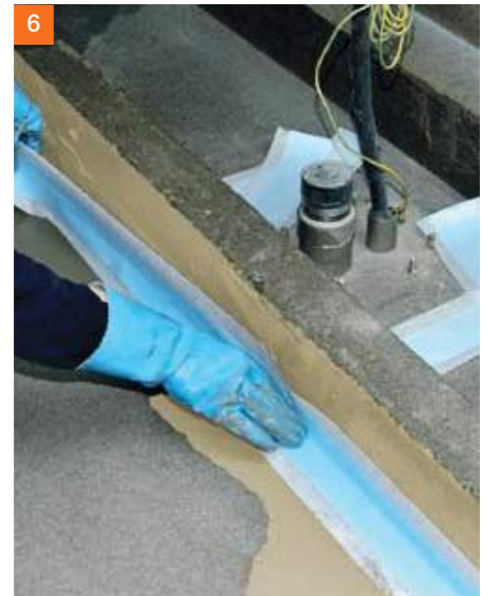
Danach wird zum Beispiel PCI Pecitape® 120 oder PCI Pecitape® Objekt eingelegt und übergearbeitet.
