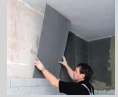
PCI PowerBoard-Element ansetzen und anschließend anklopfen.
