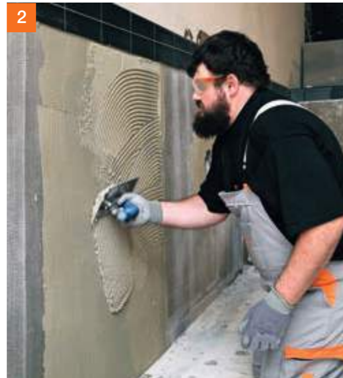
Anschließend den Kleber aufkämmen ...
