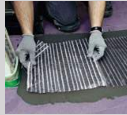
Die Glasfaserstränge der PCI Armiermatte GFS in die frische Vorspachtelung einlegen.
