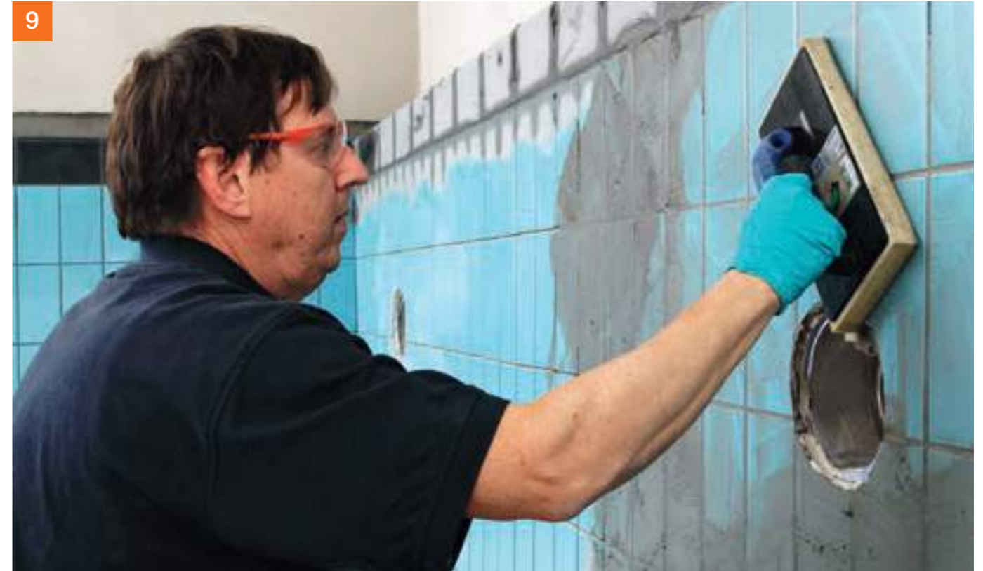
... und vorwaschen, sobald der Fugenmörtel stabil genug ist ...
