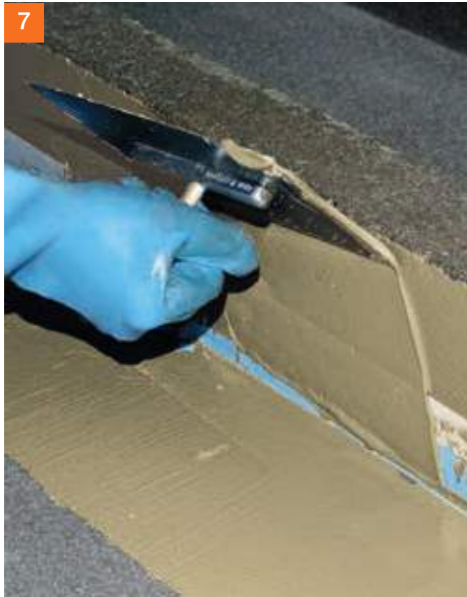
Anschließend noch einmal mit PCI Apoflex® überarbeiten.
