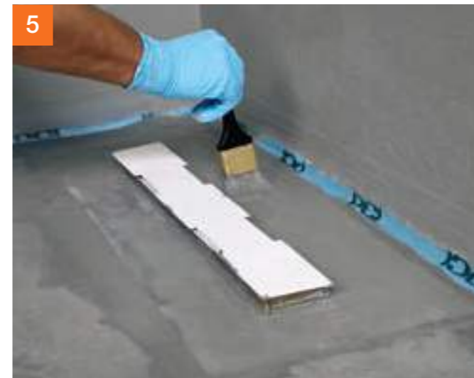
... und mit etwas Abdichtungsmaterial nochmals überstreichen.
