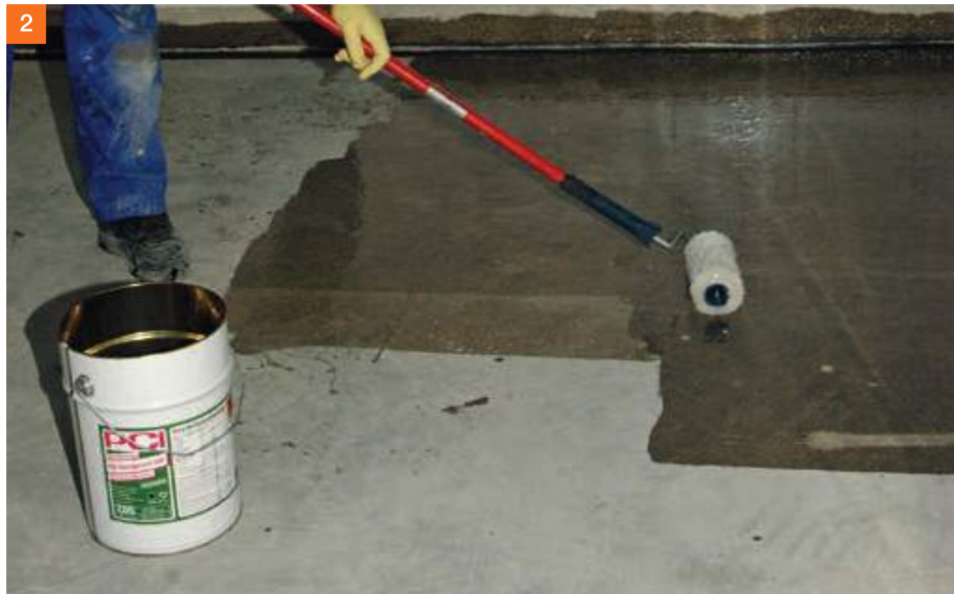
Untergründe vorbereiten, Verunreinigungen und nicht tragfähige Bereiche entfernen und ausgleichen. Mit PCI Epoxigrund 390 grundieren und absanden.
