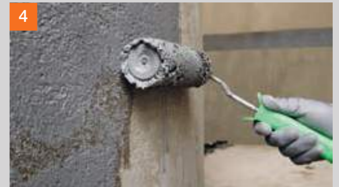
4 Tipp: Rollgrundierung mit verdünntem PCI Seccoral® 1K / 2K Rapid ausführen. Alle weiteren Arbeitsschritte finden Sie im Kapitel „Untergründe sicher abdichten“ ab Seite 40.
