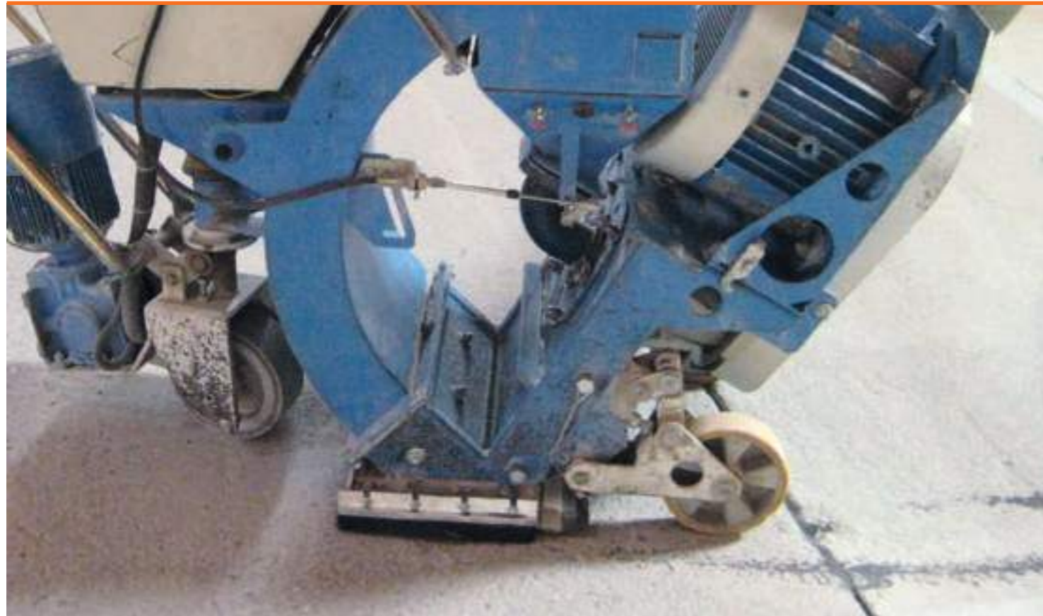
Kugelstrahlgerät Optimal vorbereitete Oberfläche mit freiliegendem Korngefüge, ohne Schmutz und haftungsmindernde Rückstände
