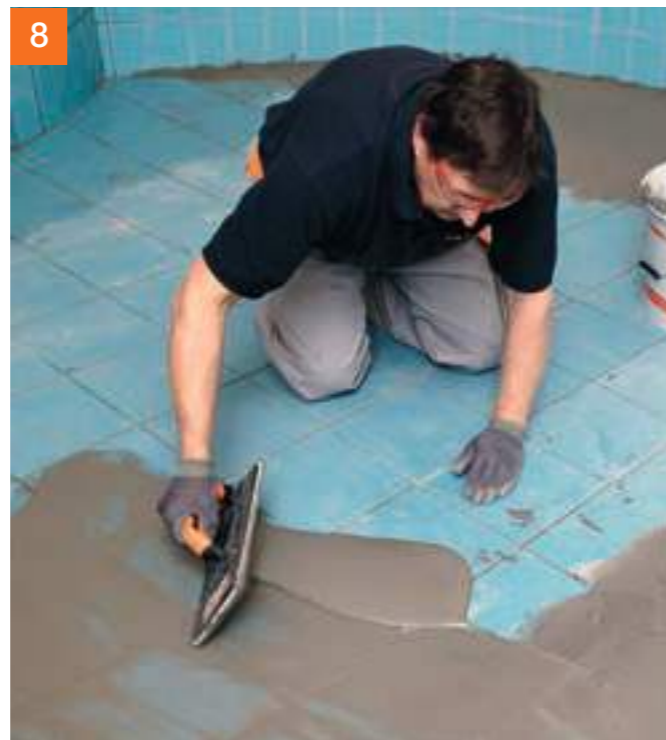
Am nächsten Tag erfolgt die Verfugung, zum Beispiel mit PCI Durafug® NT. Die Fläche einschlämmen ...
