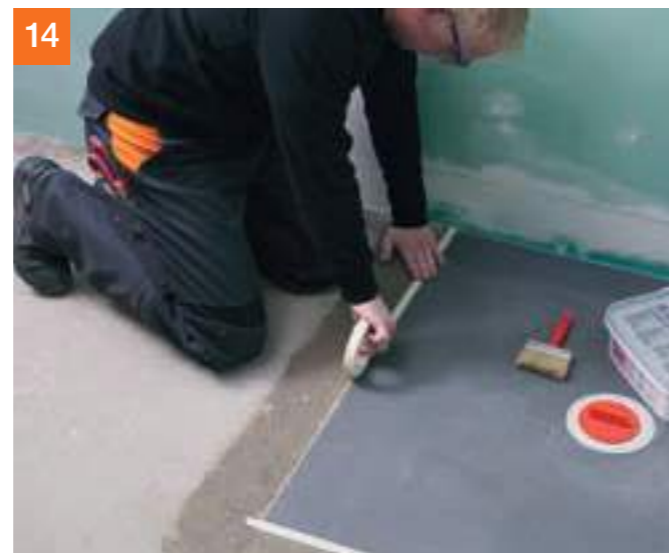
14 Tipp: Kleben Sie den schallentkoppelnden Randdämmstreifen mit einem Klebeband ab. Dann kann dort nichts dazwischenlaufen.
