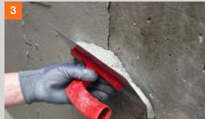
3 Fläche mit PCI Pericret® egalisieren.
