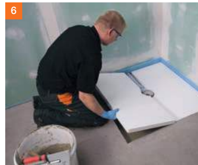
Die Platten werden untereinander mit einem Klebemörtel, zum Beispiel PCI Flexmörtel® S1, verklebt.
