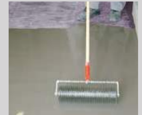
... und mit einer geeigneten Stachelwalze entlüften.
