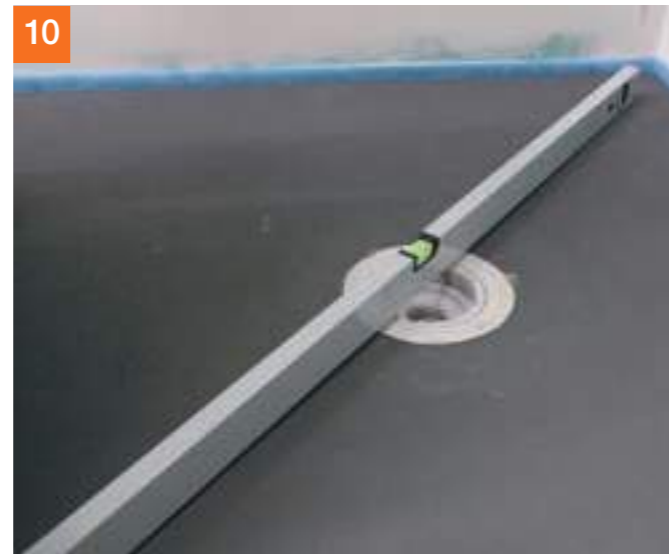
10 Korrekten Einbau mittels Wasserwaage prüfen und ...
