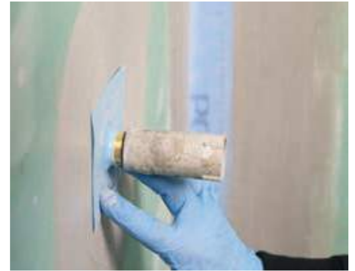
und Dichtmanschette PCI Pecitape 10x10 in das frische Material einlegen.
